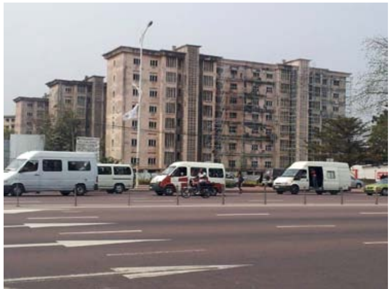
Bild 4. Das Immeuble Royal ist ein bekanntes Apartmentgebäude im Stadtteil Gombé in Kinshasa. Es wurde in den 1950er-Jahren errichtet. Ehemals Sitz der Vereinten Nationen in der DR Kongo, wurde die Mehrzahl der Apartments 2013 von Privatpersonen gemietet, die die Räumlichkeiten zu angeblich „erschwinglichen“ Preisen untervermieteten. 53
